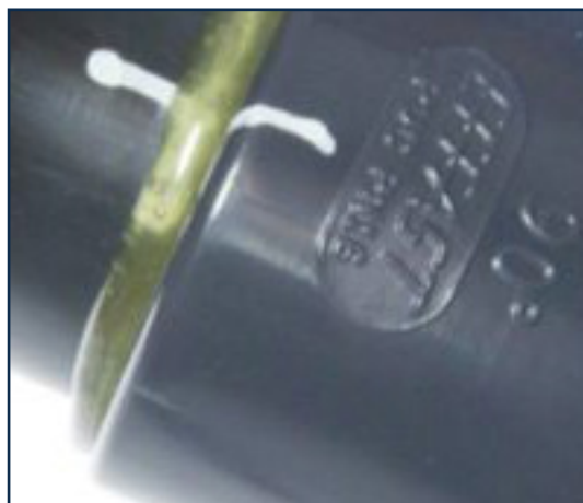
Prawidłowo wykonanie połączenie klejone.
