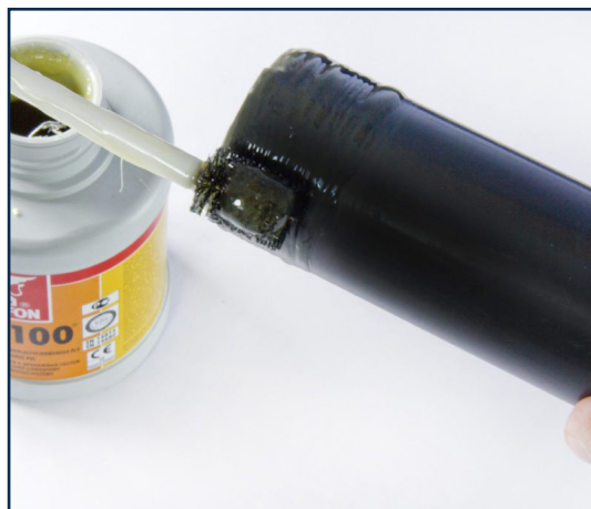
Nanieś na klejone powierzchnie warstwę kleju.
