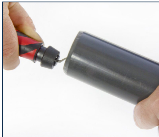
Oczyszczenie wewnętrznej krawędzi rury przed klejeniem.
