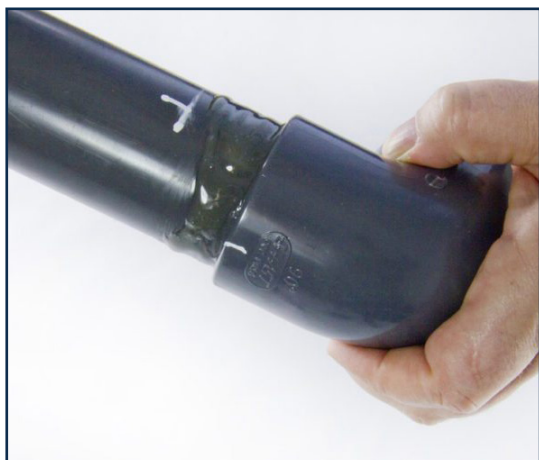
Wsunąć łączone części i wykonać obrót o 15 stopni.
