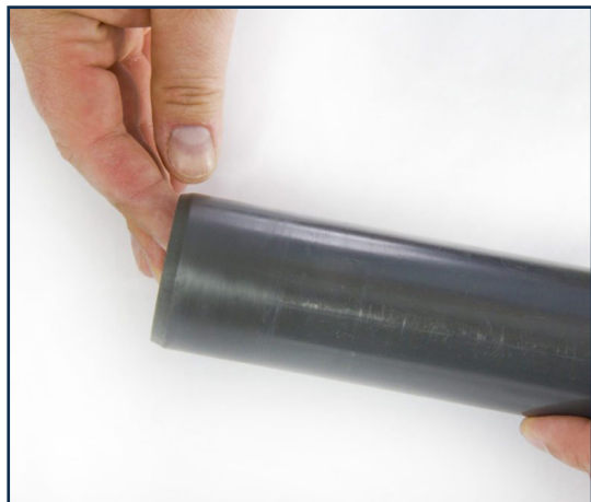
Powierzchnia po prawidłowym wyczyszczeniu powinna być matowa.
