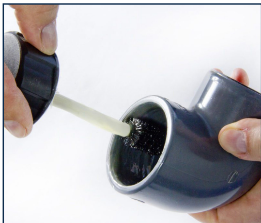
Nanieś na klejone powierzchnie warstwę kleju.
