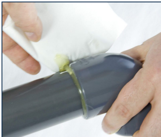
Usunięcie nadmiaru kleju po wykonaniu połączenia.
