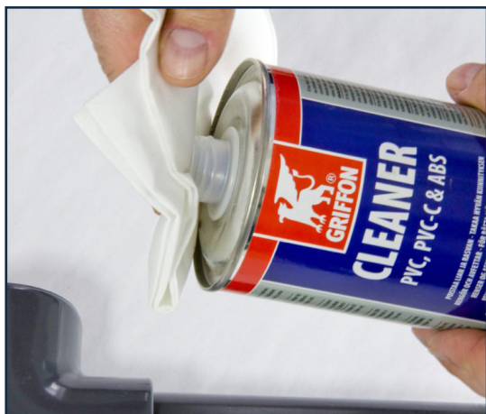
Namocz czystą szmatkę w zmywaczu.
