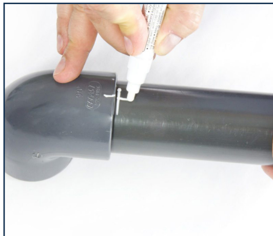
Zaznacz punkt spasowania rury i kształtki.
